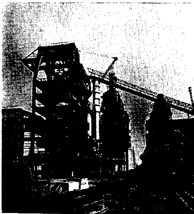
Photo 5. — Hauts-fourneaux d'Usinor à Dunkerque. Les blindages des hauts-fourneaux et les cheminées de cowpers de 75 mètres de hauteur sont métallisées à l'aluminium en 20/100 e d'épaisseur.
